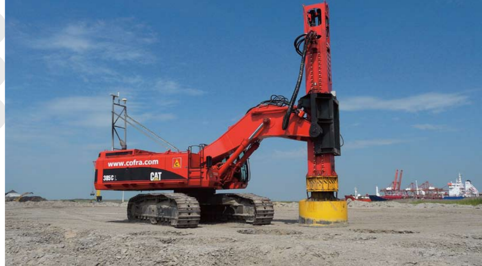
Уплотнение на строительной площадке терминала Ворак
