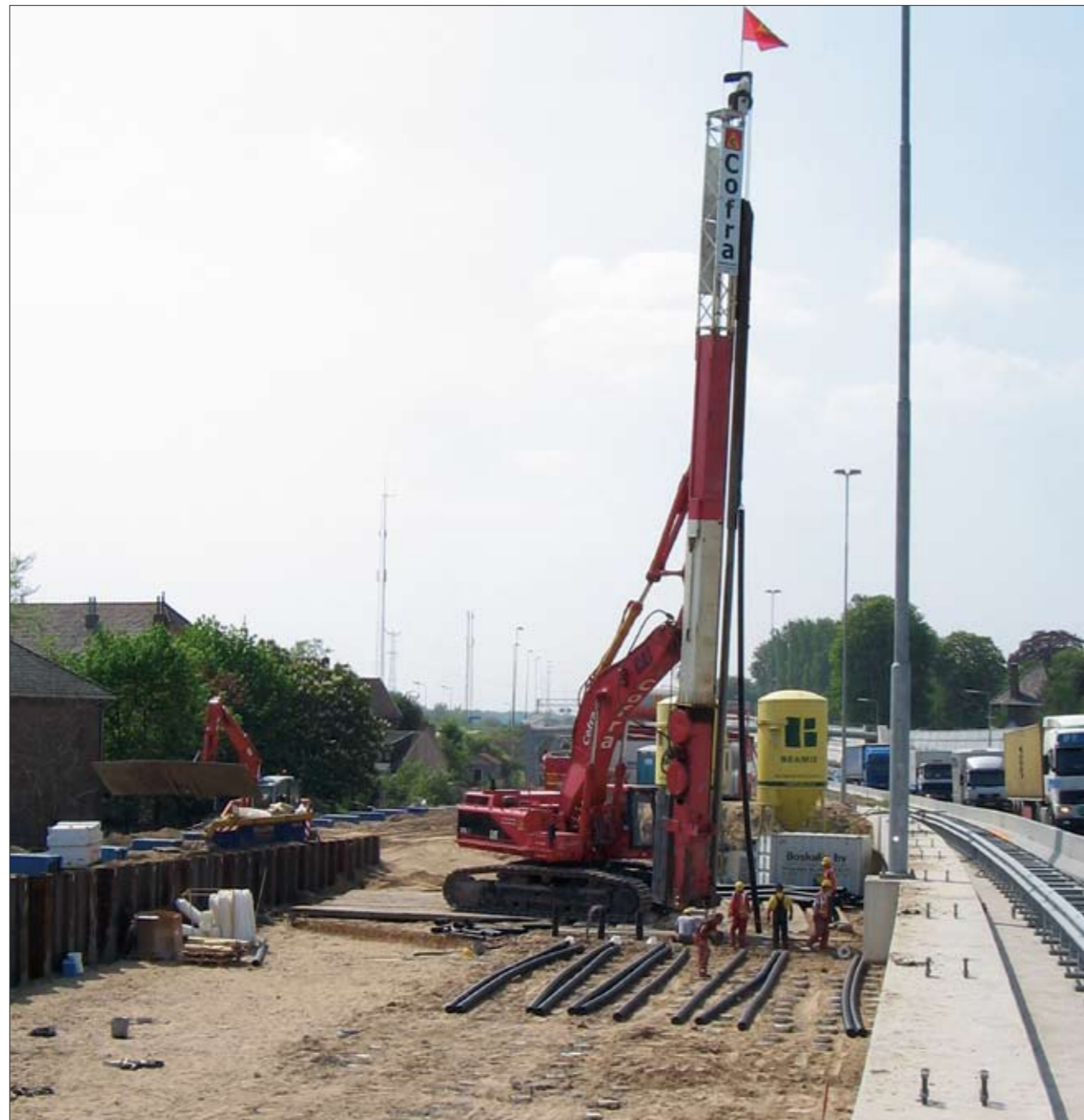
Установка свай AuGeo для южных проезжей автомагистраля A15
